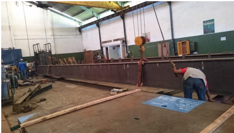
Gambar 1.3 Girder yang siap full welding (1 girder)
