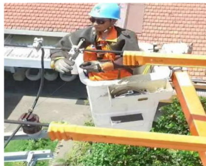
Gambar 2.4 MBJ dipakai saat mengupas konduktor
