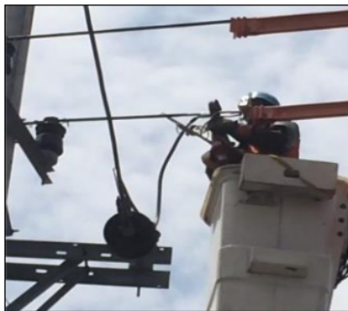
Gambar 2.2 MBJ dipakai pada saat pekerjaan penggantian konektor jumperan (LLC ke LTC) fase T pada konstruksi TM Percabangan
