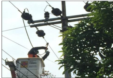
Gambar 2.3 MBJ dipakai pada saat pekerjaan penggantian jumperan fase R TM lurus
