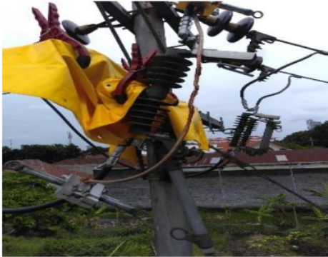
Gambar 2.6 MBJ dipakai pada saat pekerjaan penggantian Fuse Link FCO Branch
