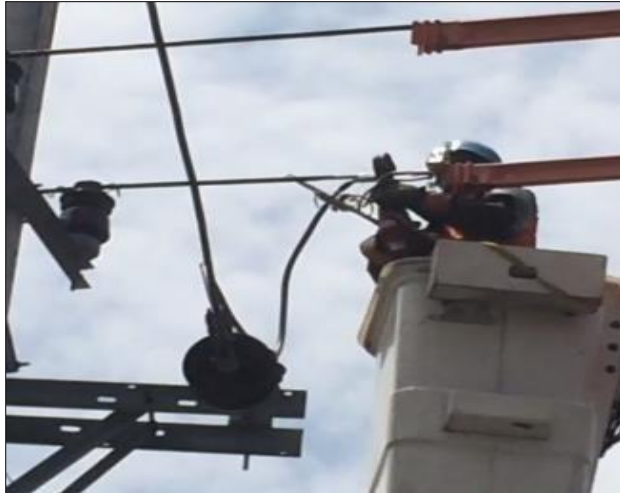
Gambar 3.2.1 MBJ dipakai pada saat pekerjaan penggantian konektor jumperan (LLC ke LTC ) fase T pada konstruksi TM Percabangan
