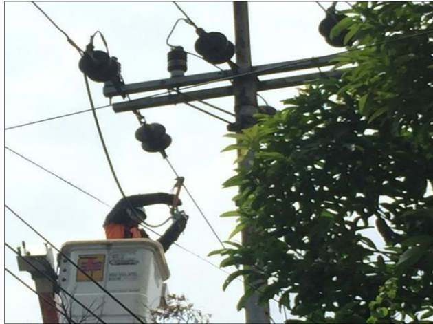
Gambar 3.2.2 MBJ dipakai pada saat pekerjaan penggantian jumperan fase R TM lurus
