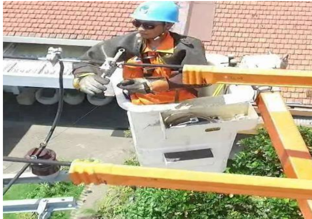
Gambar 3.2.3 MBJ dipakai saat mengupas konduktor
