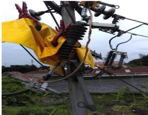
Gambar 3.4.5 MBJ dipakai pada saat pekerjaan penggantian Fuse Link FCO Branch
