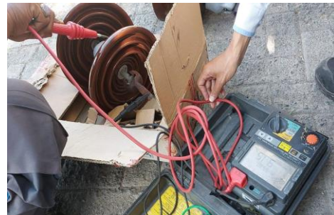
Gambar 4. 4 Proses Uji Tahanan Isolasi
