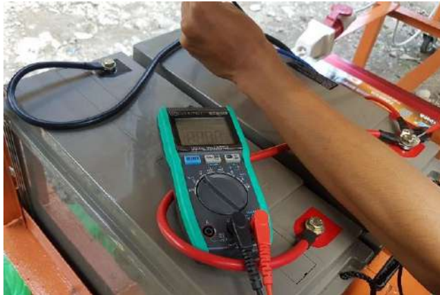
Pengukuran Tegangan Pada Baterai
