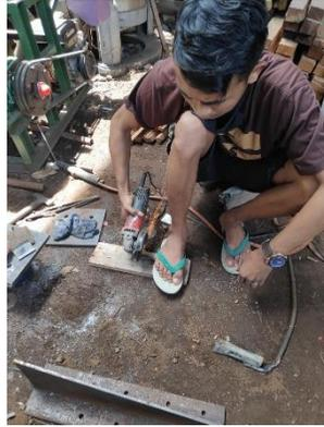
Peroses pemotongan baja st 60
